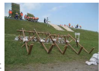
水防工法事例: 杭打ち積土のう工
