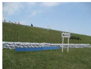
水防工法事例: 積土のう工
