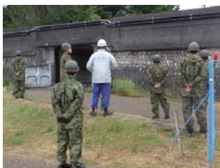
重要水防箇所共同点検 (愛知県一宮市内)
